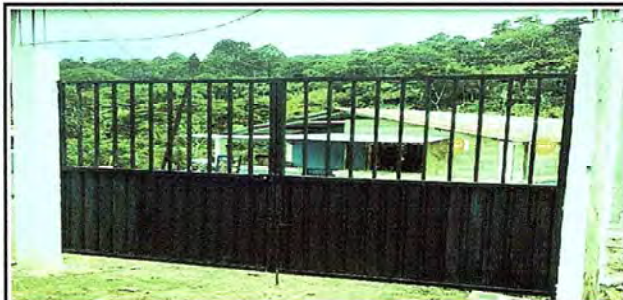
Foto 4: Sustitución de Portones de Metal terminada.
