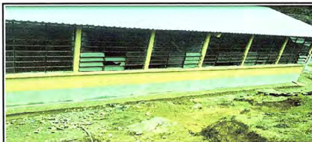
Foto 5: Repello de paredes atrás de dos aulas y dirección.
