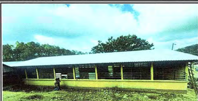
Foto1: Laminas nuevas de dos aulas y dirección.
