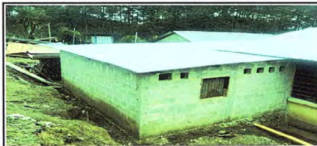
Foto 6: Ampliación de cocina de block terminada.
